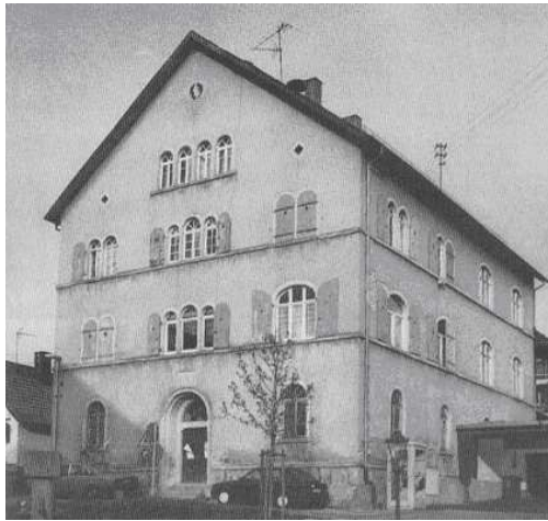
Fassade der Schule vor der Sanierung
