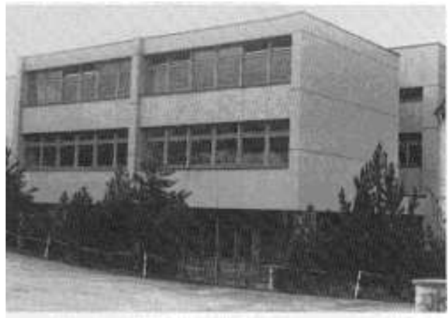
Erweiterungsgebäude von 1977/78 links hinter dem Altbau von 1926
