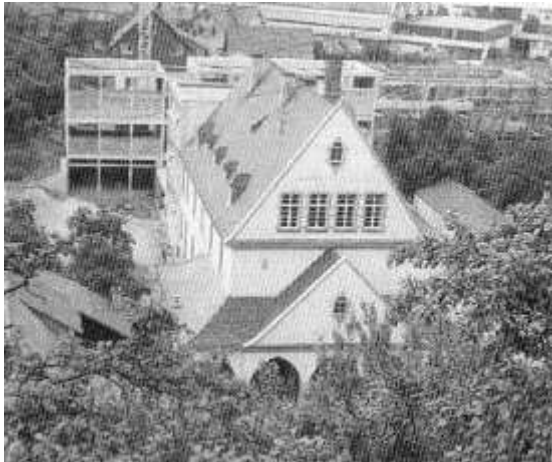
links im Hintergrund: Erweiterungsarbeiten von 1977/78
